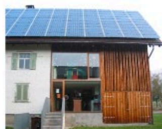
Un ensemble de capteurs recouvre toute la surface du toit, comme une nouvelle couverture. Crèche à Zwischenwässer (Vorarlberg, Autriche) © CAUE 78
