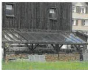
Les capteurs sont intégrés à la couverture d'une remise à côté. Maison individuelle (Vorderberg, Autriche) © PNR du Vexin français
